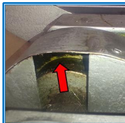
(Photo n°48 : Vue de la partie haute du protecteur)
