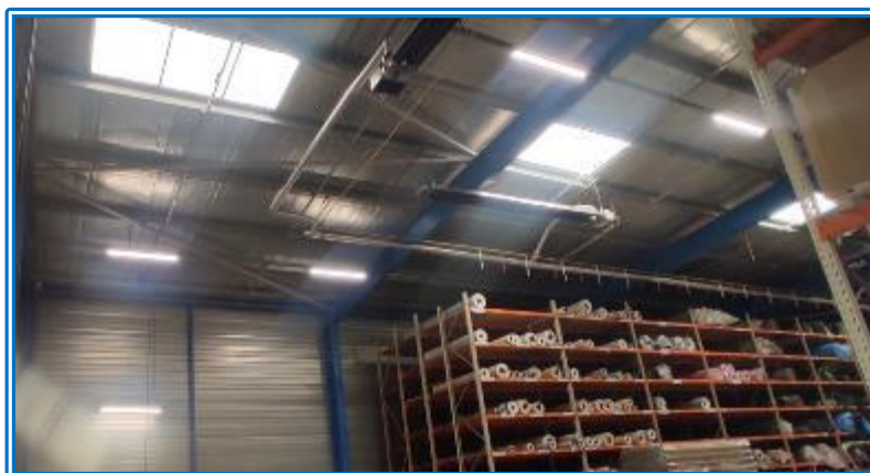
(Photo n°32 : Vue du plafond de l'entrepôt)
