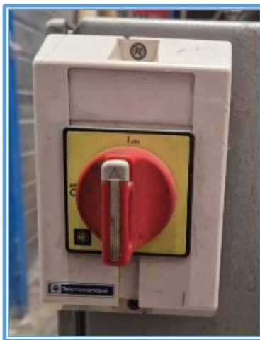
(Photo n°16 : Vue du sectionneur rotatif)
