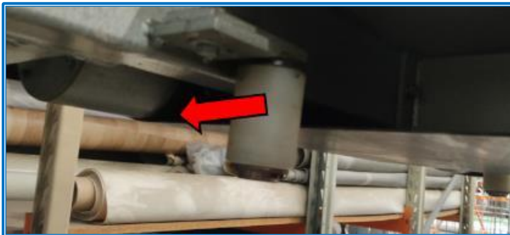
(Photo n°45 : Vue de la partie basse du convoyeur à bandes)
