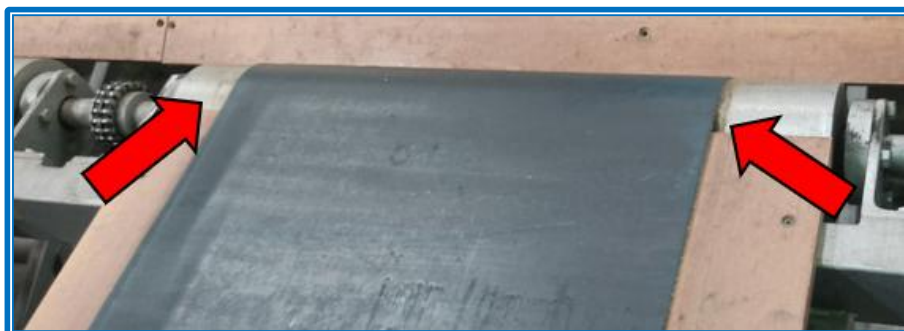
(Photo n°46 : Vue de la partie basse du convoyeur à bandes)
